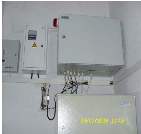
а) с. Олександрівка ППК-9 (радіошафа, пульт пожежної сигналізації, щиток розподільний)
