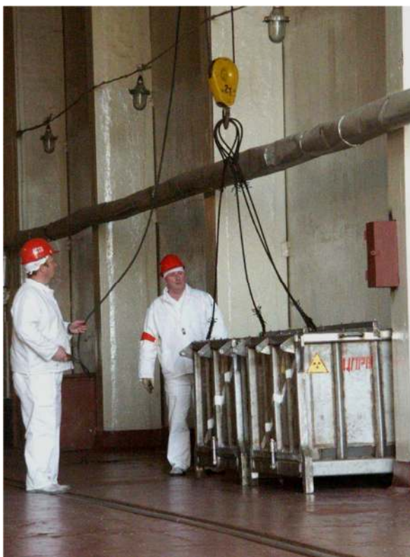
Контейнер-збірник ТРВ перед транспортуванням у СТРВ СК.
