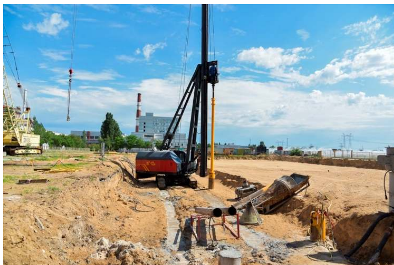
Початок будівництва сховища легкого типу
